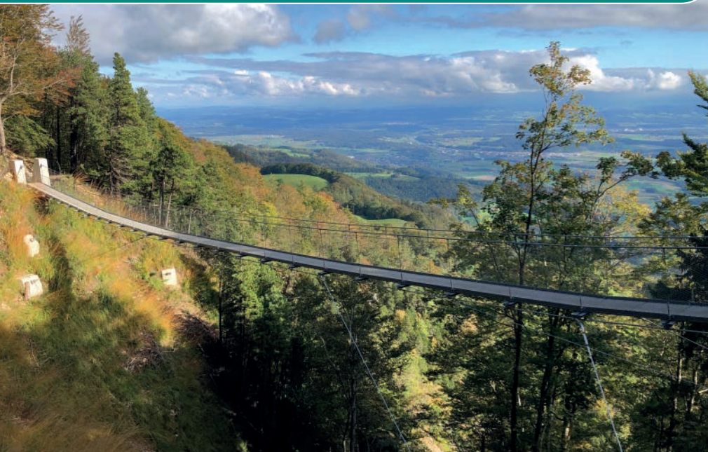
Die Seilbrücke sorgt für sichere Passage des Steinschlaggebiets «Gschliff».
