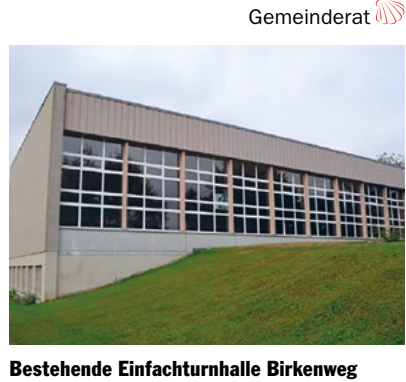
Bestehende Einfachturnhalle Birkenweg
