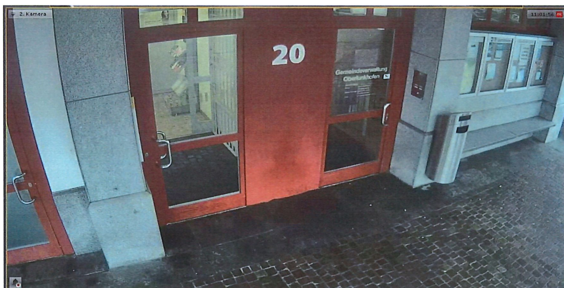
Aufnahmebereich Eingangsbereich Zugerstrasse 20, Erdgeschoss
