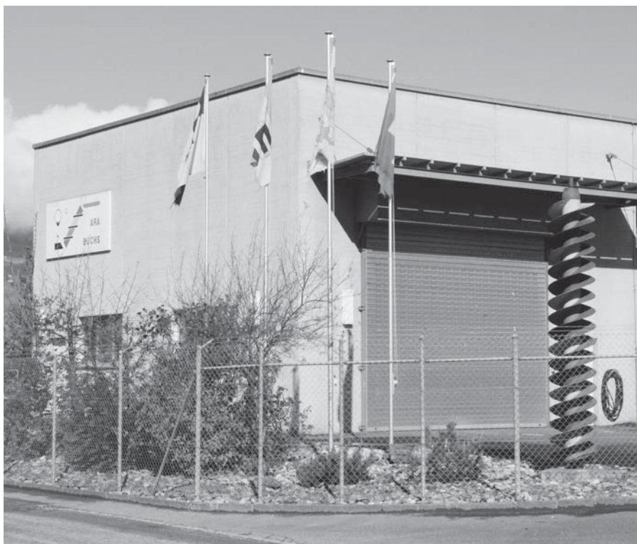
Die ARA hat nun viele Jahre gute Dienste getan – jetzt muss sie saniert werden.
