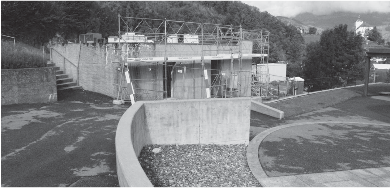
Die Sanierungsarbeiten an der Aufbahrungshalle auf dem Buchser Friedhof haben begonnen.
