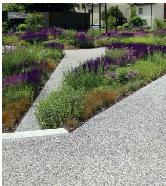
Référence revêtement chaussée, Colbille, Martigny
