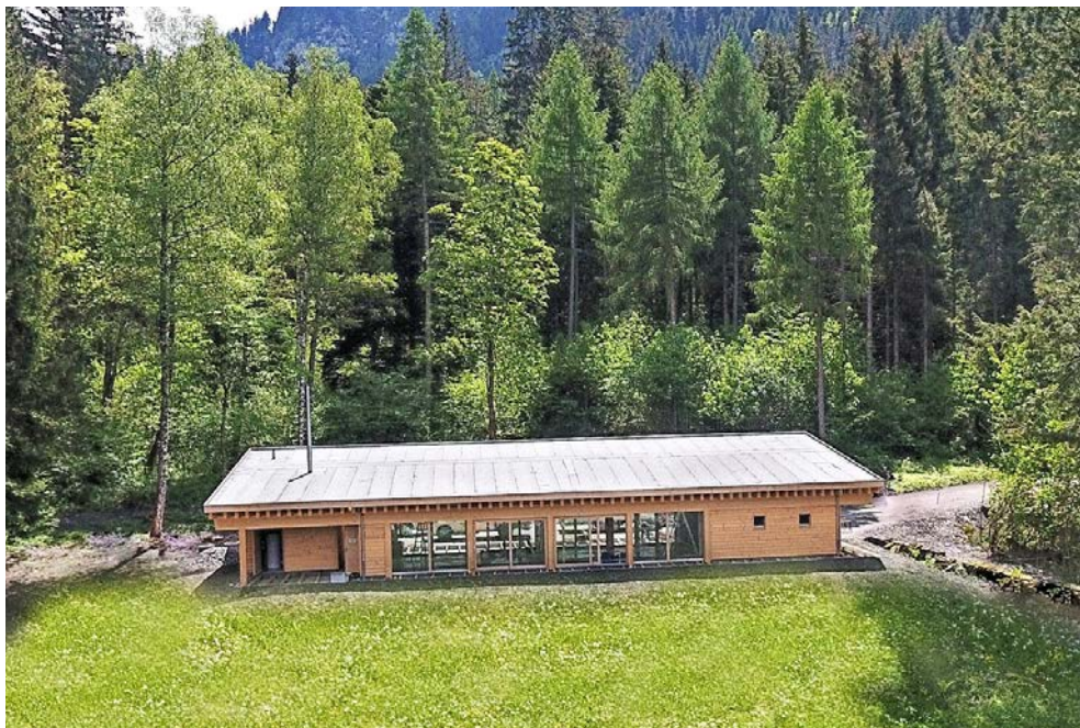
Crappasusta: Die Fassade der neuen Waldhütte wurde mit Fichtenholz aus dem Thusner Wald verkleidet. Grosse Fenster machen den Innenraum gemütlich und einladend.
