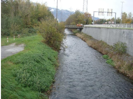
Abbildung 4: Westliches und östliches WBK-Ufer von der südlichen Projektgrenze mit Blickrichtung Nord zur bestehenden Brücke WBK Langäulistrasse Anschluss Buchs, 28.10.2022.
