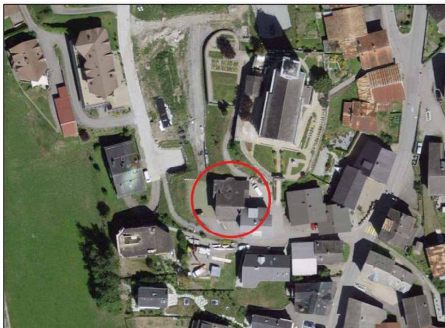
Bestehendes Gebäude «Sentupada» der Kirchgemeinde Laax
