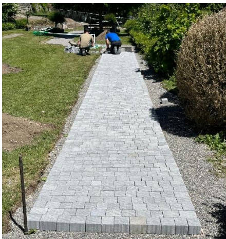
Ein rollstuhlgerechter Zugangsweg bis zur Gemeinschaftsgrabanlage wird errichtet.
