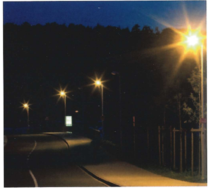
Situation avec une mauvaise uniformité
