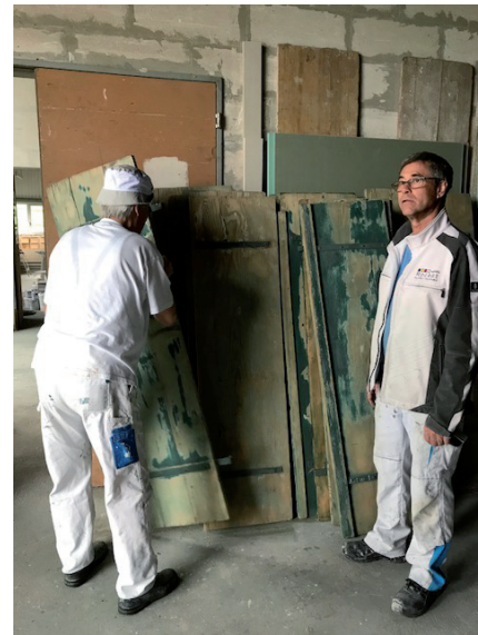
entreprise Rochat, réparation et peinture des volets existants NCS S7010-G30Y
