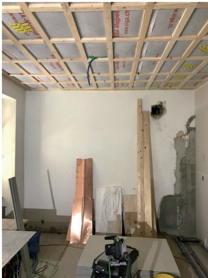
lattice du plafond de l'étage pour isolation entre solivages
