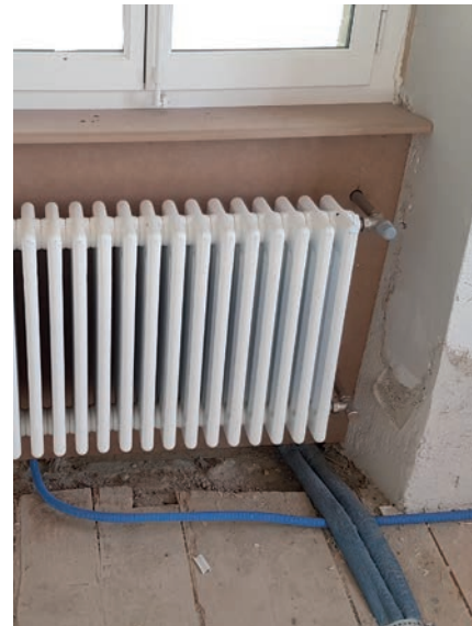
pose des contre cœurs et tablettes de fenêtres ainsi que des radiateurs et conduites de chauffage
