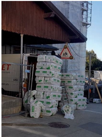
insufflation de l'isofloc par l'entreprise Jotterand
