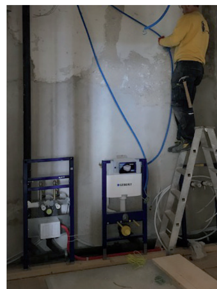
sanitaire : pose des châssis pour lavabo, wc et baignoire dans chaque salle-de-bain
