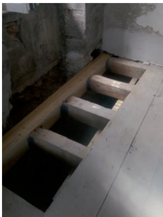
consolidation des têtes de solivage par le charpentier
