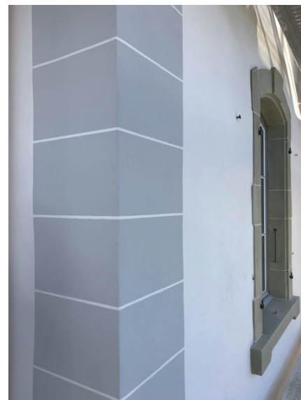
détail du chaînage d'angle peint
