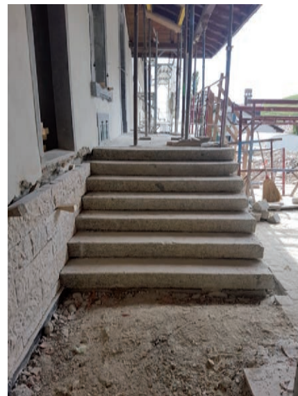
pose sous le couvert des marches existantes de l'escalier en pierre
