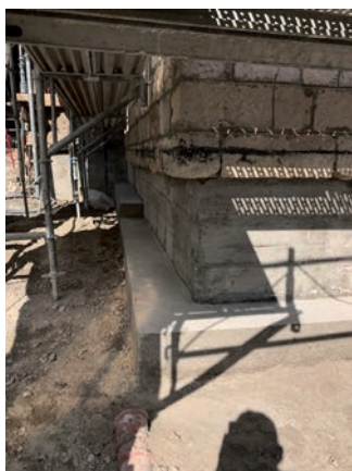
soubassement prêt pour le travail du tailleur de pierre
