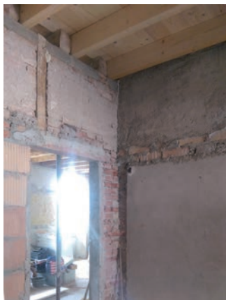
remplacement du plancher sur l'ancienne buanderie
