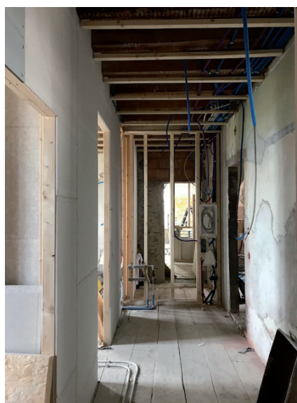
électricité : passage des tubes dans le doublage plafond
