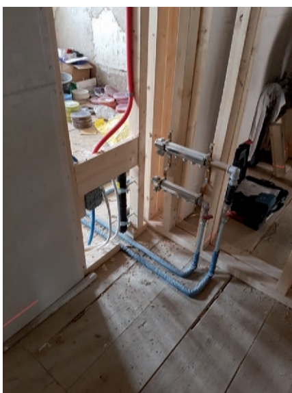
chauffage : pose des collecteurs dans chaque appartement
