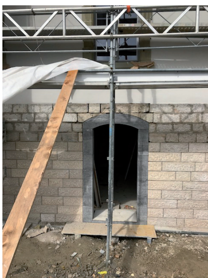
pose de l'embrasure en St-Triphon de la porte côté jardin
