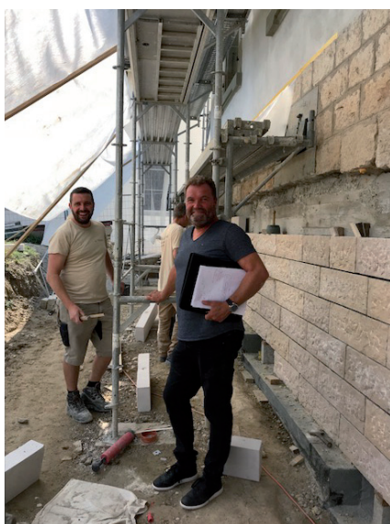
entreprise Lachat à l'oeuvre, pose pierre de soubassement
