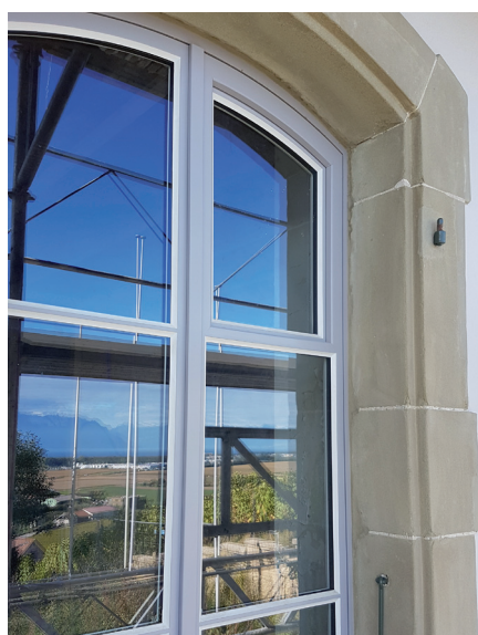
pose des nouvelles fenêtres au rez et étage
