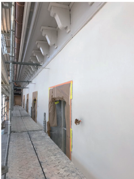
première couche de peinture façade BO-087-1 avant toit et modillons BO-089-1
