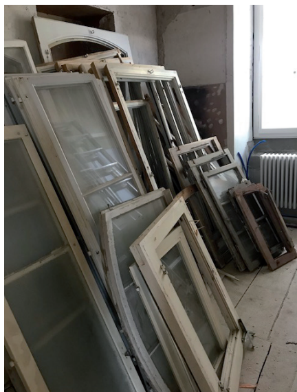
démontage et évacuation des anciennes fenêtres
