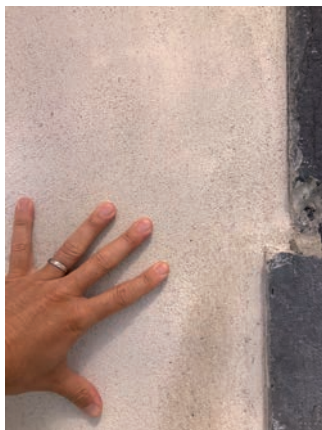
crépi de finition embrasure en pierre de St- Triphon
