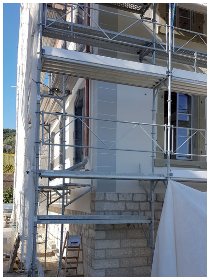
deuxième couche de peinture façade BO-087-1 et chaînage d'angle par le peintre
