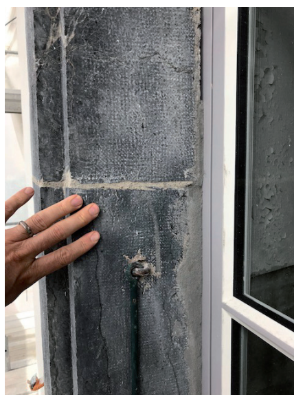
joints et rhabillage des embrasures de pierre par l'entreprise Lachat
