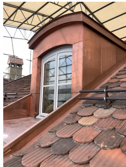
pose des nouvelles fenêtres dans les combles
