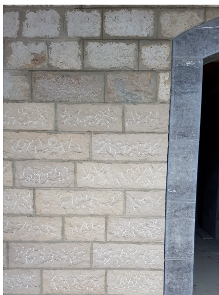
joints du soubassement par l'entreprise Lachat
