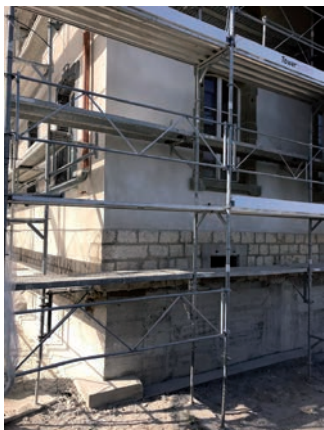
crépi de façade terminé le 26.07.19, en cours de séchage
