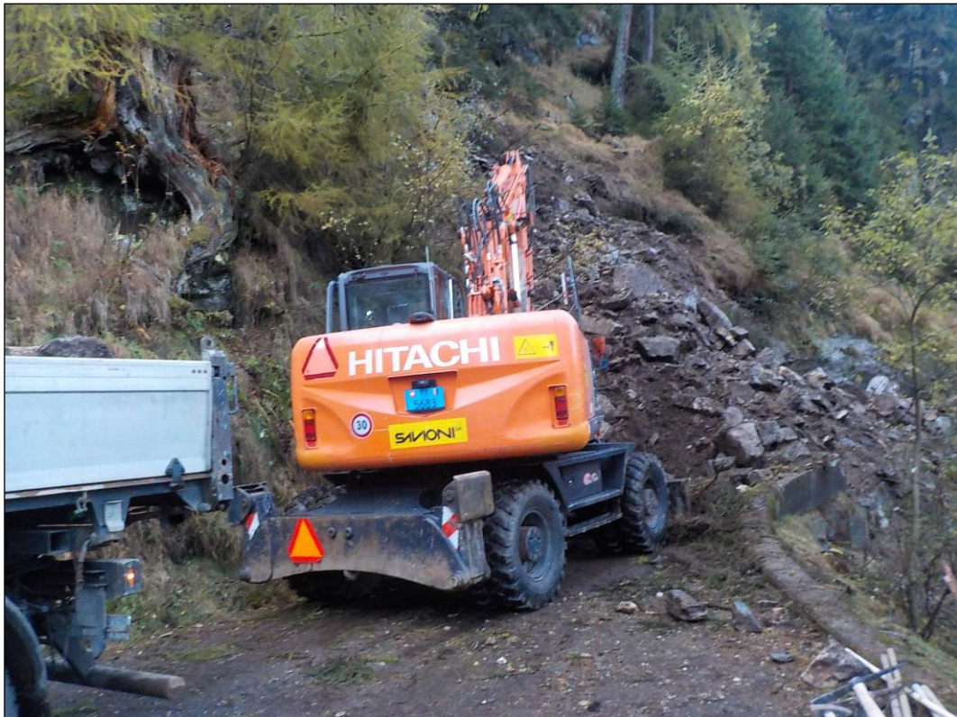
Foto 5: Lavori urgenti di sgombero del materiale (27.10.2023).
