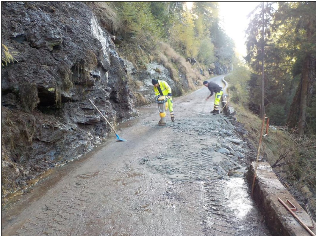
Foto 6: Lavoro di ripristino parziale del campo stradale (27.10.2023).
