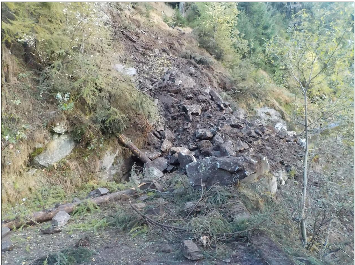
Foto 4: Deposito del materiale franato sulla strada forestale.
