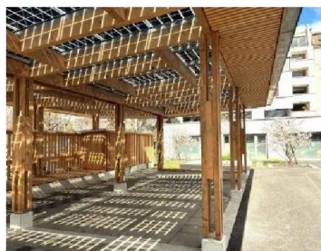
Vue de la charpente et des panneaux solaires
