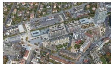
Vue 3D par drone du quartier de la gare, © uzufly/ octobre 2025.
