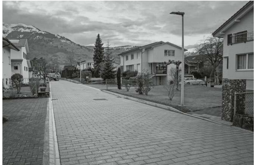
In der Kleestrasse wurden erstmalig Verbundsteine als Fahrbahnbelag verbaut. Dieser helle Belag heizt sich weniger auf als dunkler Asphalt.
