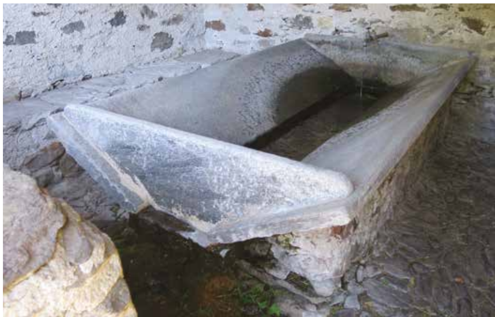
La vasca del lavatoio
