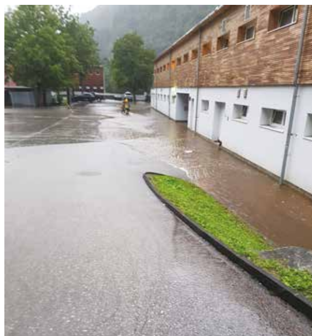
Allagamento al Centro sportivo di Sornico
