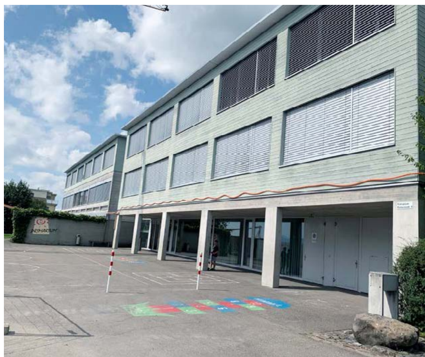
■ Das Primarschulhaus muss statisch saniert werden.
