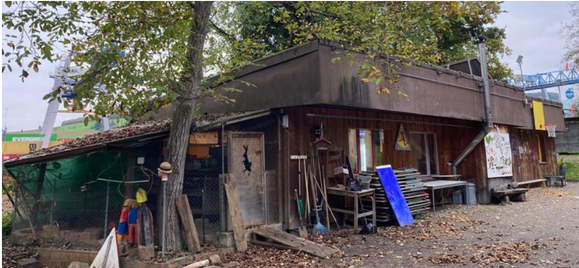
Abb.1: bestehendes Hauptgebäude mit anliegendem Nagergehege.
