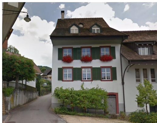
Abb. 32: Rundgaube Parzelle Nr. 347 (Quelle: Google Street View, April 2023)
