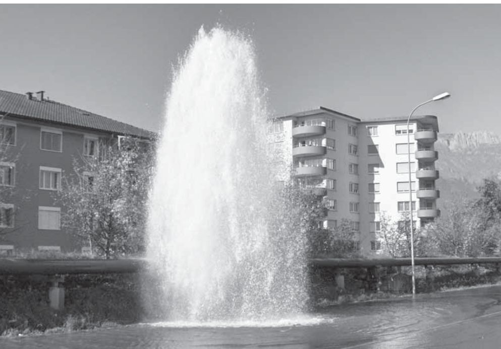
Piketteinsatz Wasser- und Stromversorgung
