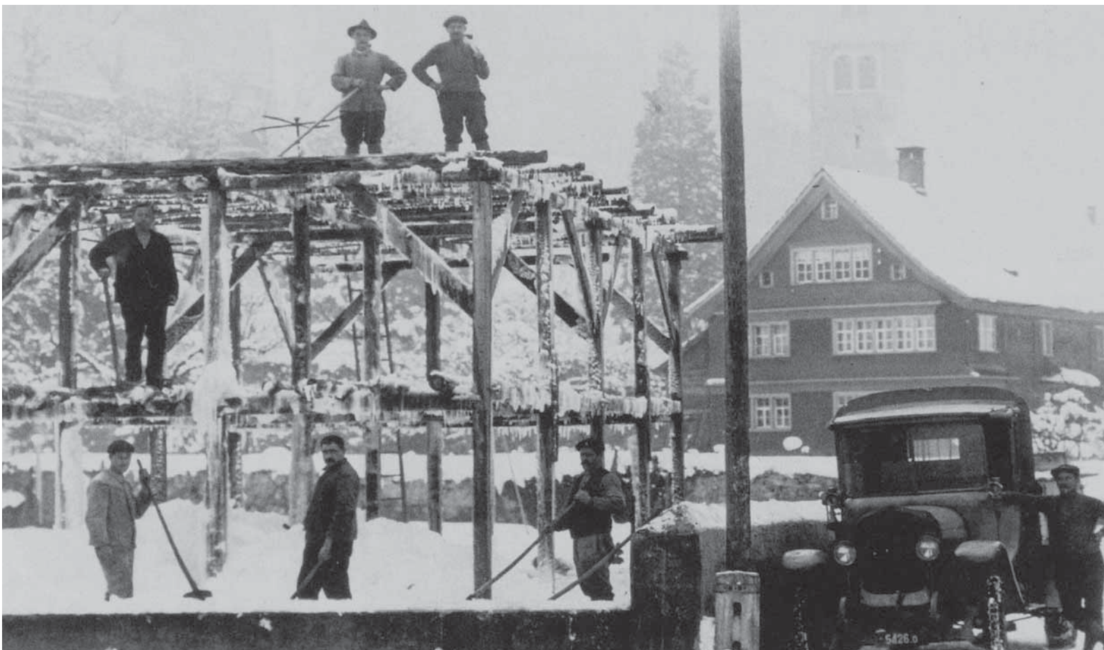
Mit Wasser berieselter Eisgalgen zu Herstellung von Natureis als Kühlmittel bei der früheren Herstellung und Lagerung von Bier (Brauerei Zirfass)
