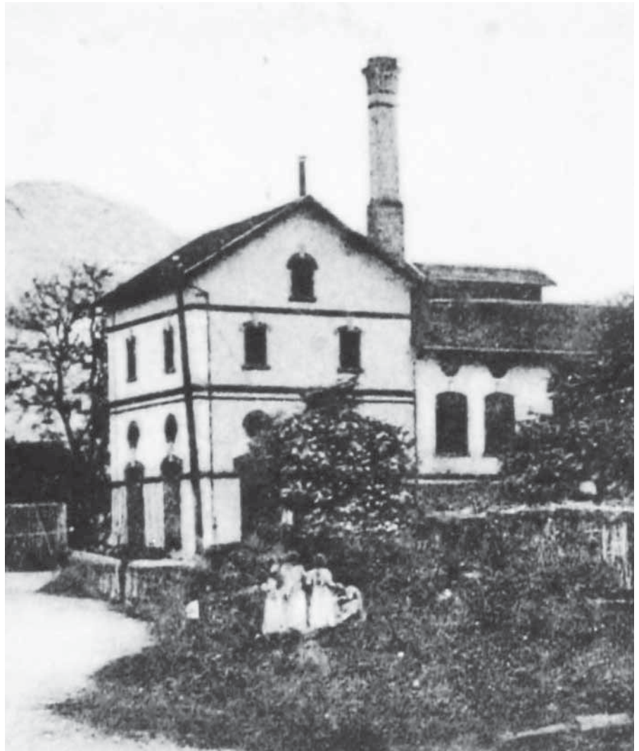
Das von Johannes Rohrer 1881 erbaute Brauereigebäude, Nebetbach
