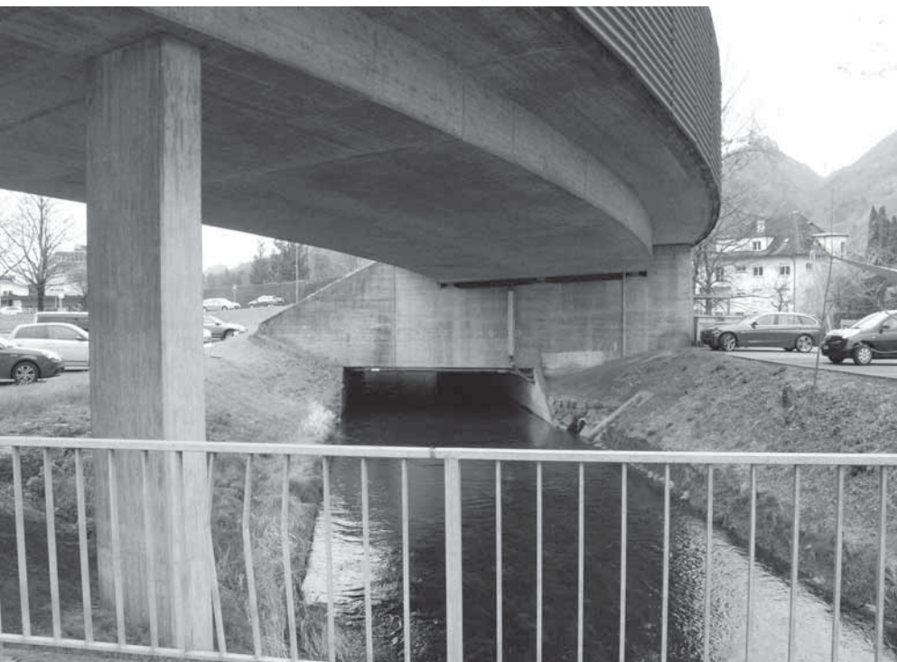
Giessen-Durchlass bei der «Rondelle»
