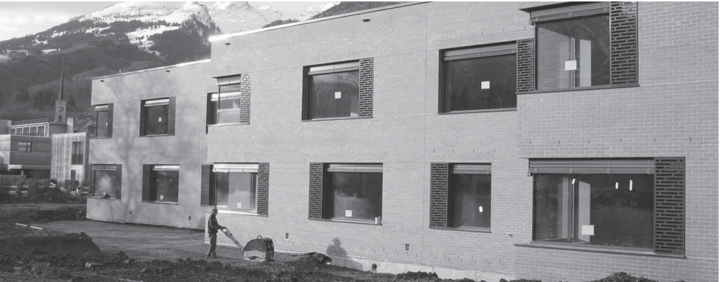
Der Boden für den befestigten Pausenbereich der neuen Kindergärten wird geplant.
