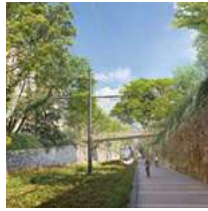
La construction du Tram des Nations a démarré
