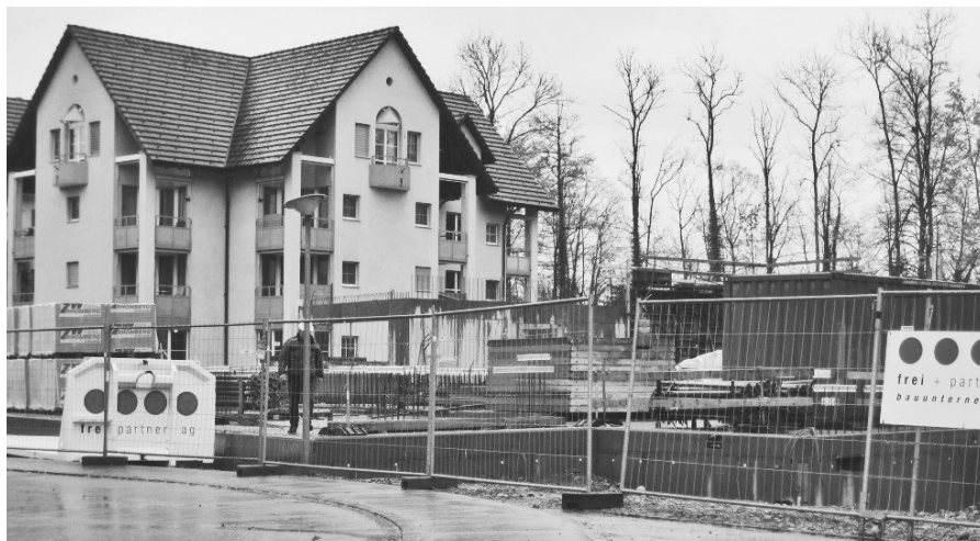
Baustelle für 19 Alterswohnungen beim Altersheim Im Park
