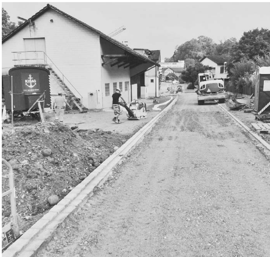
Sanierung Steinackerstrasse Kradolf
