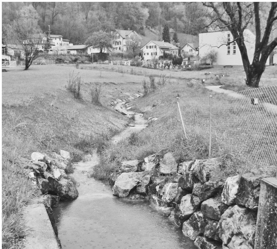
Bitzibach nach der Verlegung und Renaturierung
