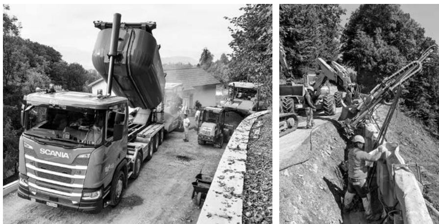
Erstellung der neuen Stützmauer bzw. Belageinbau an der Ernetschwilerstrasse
