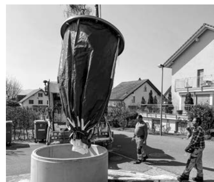
Hebung eines Unterflur-Sackbehälters mit Kran
