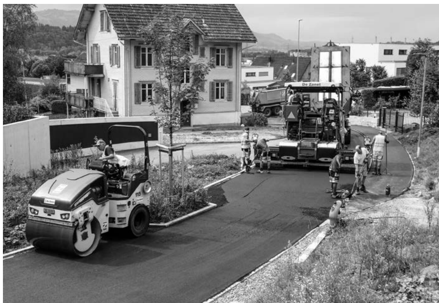
Einbau Deckbelag an der Ahornstrasse
