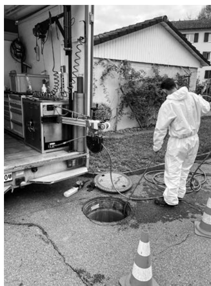
Inlinersanierung an der Gerbistrasse
