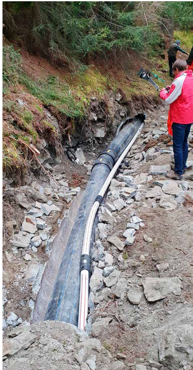
Sanierung Hangleitung Mutji
