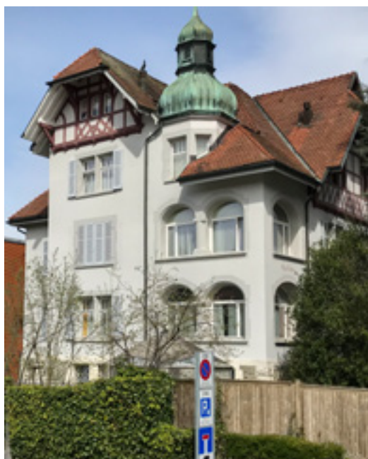
Pflegeheim Helios, Goldach
