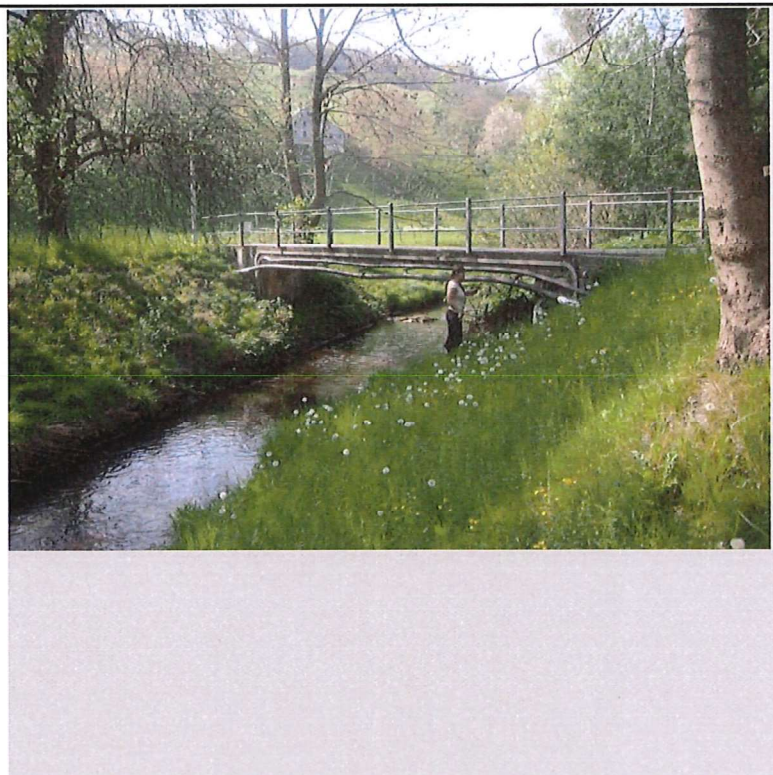
Abbildung: Brücke Stiegengässli
