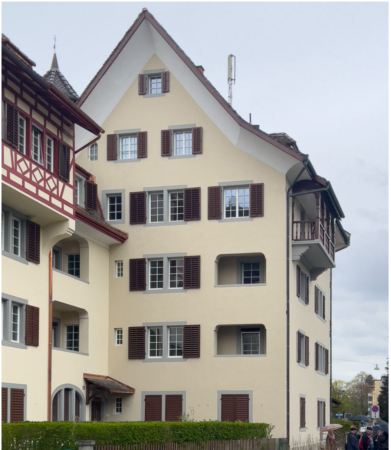
frisch renovierte Liegenschaft von Buckten in Zürich
