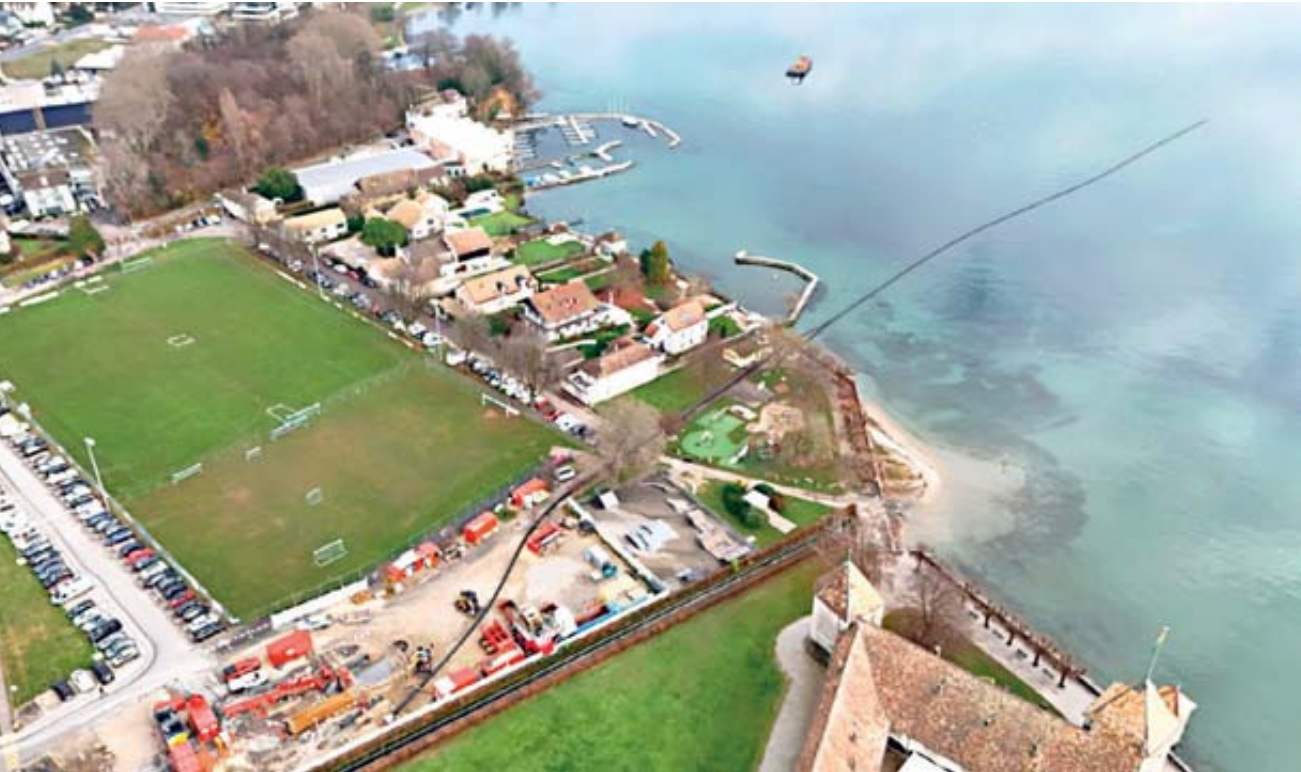
Vue du chantier de la STAP avec l'installation de forage et l'arrivée de la conduite lacustre. PHOTO : ROMANDE ENERGIE SERVICES SA
