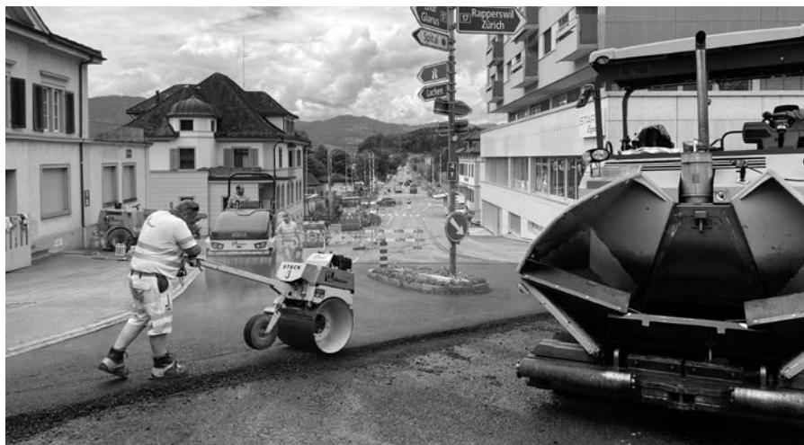
Belagsarbeiten im Städtchen
