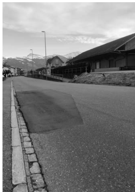
Eisenbahnstrasse abgefräst
