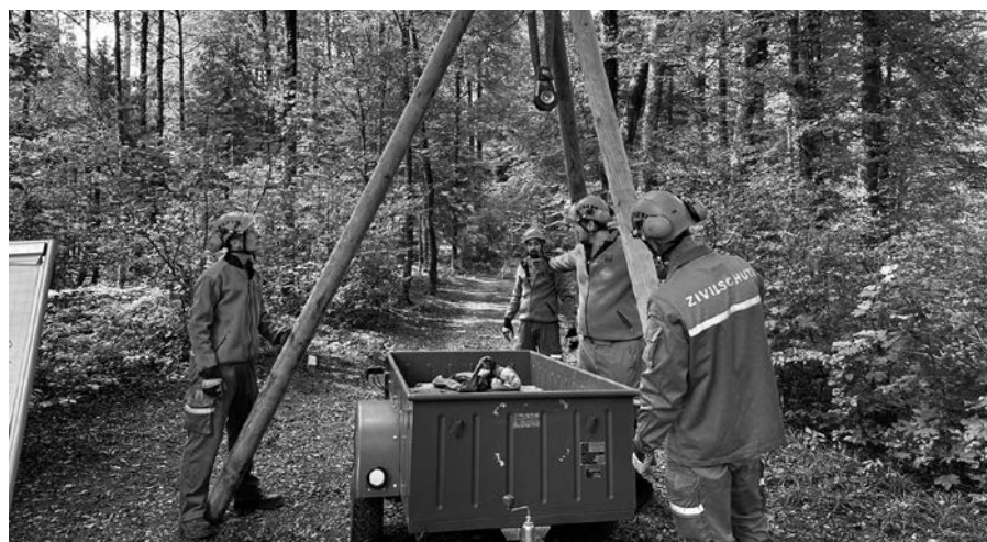
Hilfskonstruktion zum Heben von Lasten
