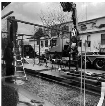
Aufbau der Pergola Süd
