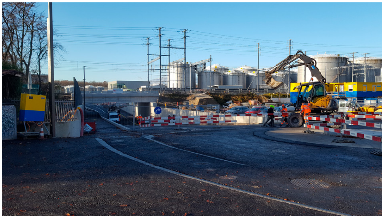
Travaux routiers sur le chemin Philibert-De-Sauvage
