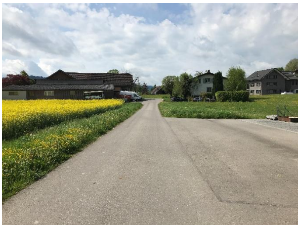
Güterstrasse 4406, Blick Richtung auf die Ausserdorfstrasse
