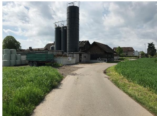
Güterstrasse 4101, Blick auf Ausserdorf 70
