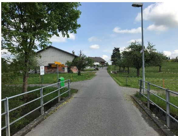
Güterstrasse 3404, Bachbrücke «Rot»
