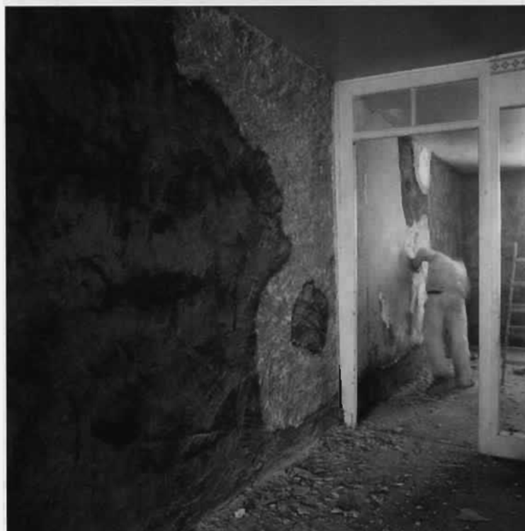
Travaux de rénovation : appartements
