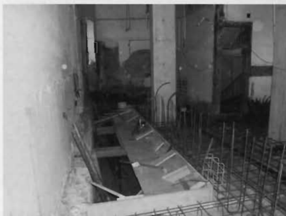
Travaux de rénovation au rez, étage et toit
