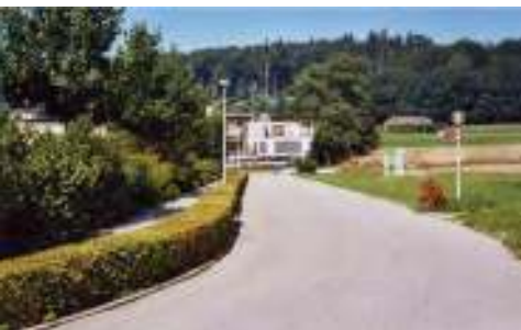
Rue du Centre sportif
