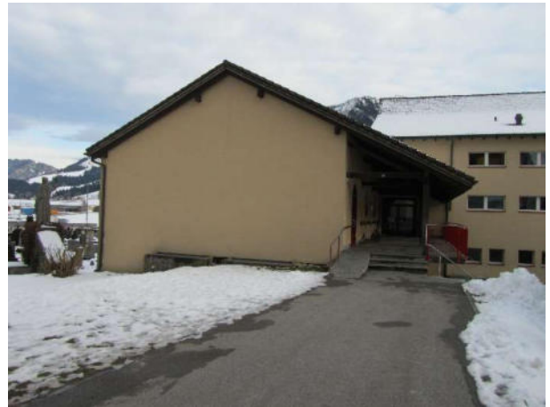
Fassadenansicht Nord-West mit Hauptzugang
