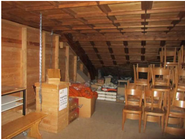
Lagerfläche über Zwischenbereich
