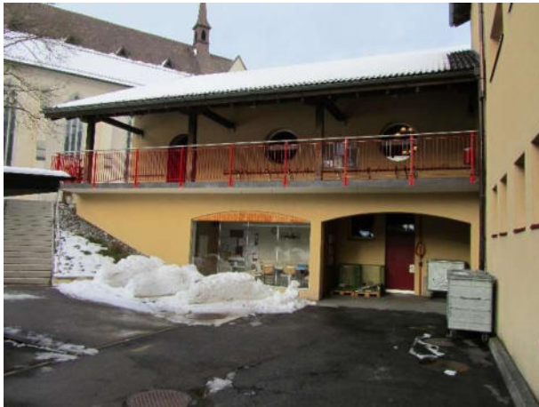
Fassadenansicht Süd-West mit Nebenzugang
