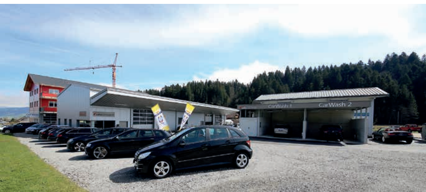
Blick auf die neuen zwei Waschanlagen.
