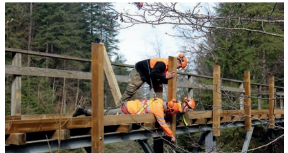
Erneuerung des Steges über den Hilfernbach.
