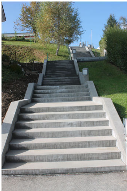
(Bildlegende:) Schulhaustreppe wird saniert
