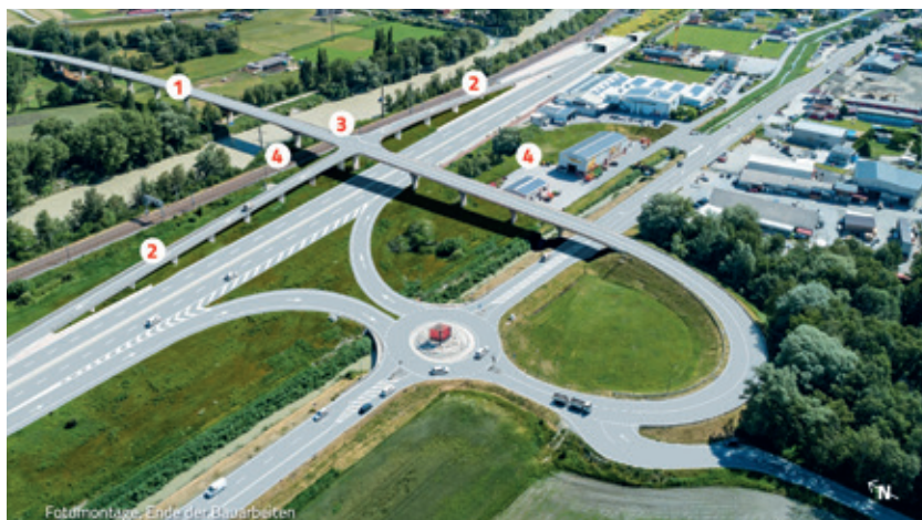
Fotomontage, Ende der Bauarbeiten
