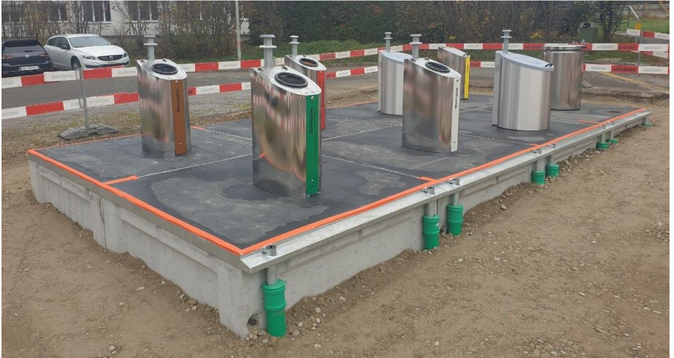
Abbildung 5: Oranges Klebeband rund um den Abschlussrahmen verhindert eine Verstopfung während der Hinterfüllung
