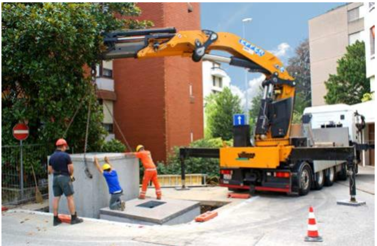
Abbildung 3: Foto einer Versetzung von Unterflur-Anlagen mit Villiger LKW
