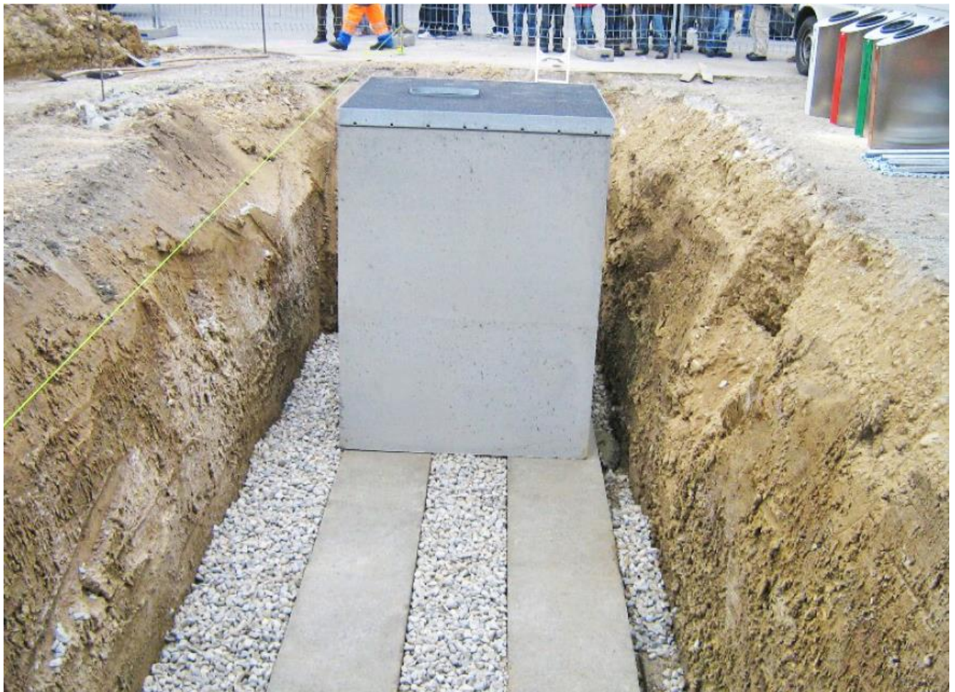
Abbildung 4: Foto eines Streifenfundaments
