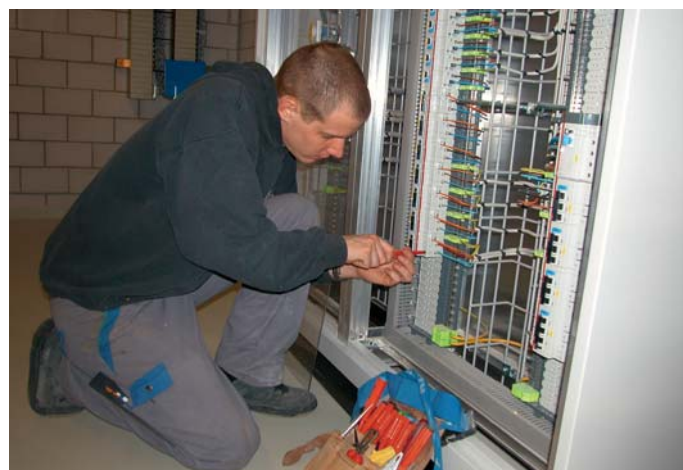
Vom Team der Elektroinstallation: Unser Elektroinstallateur Thomas Heimberg.
