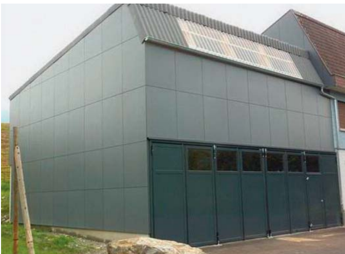
Neubau mit Einstellhalle sowie Archiv- und Lagerraum.
