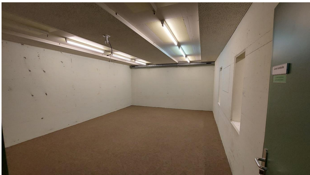
Salle de conduite (en travaux)
