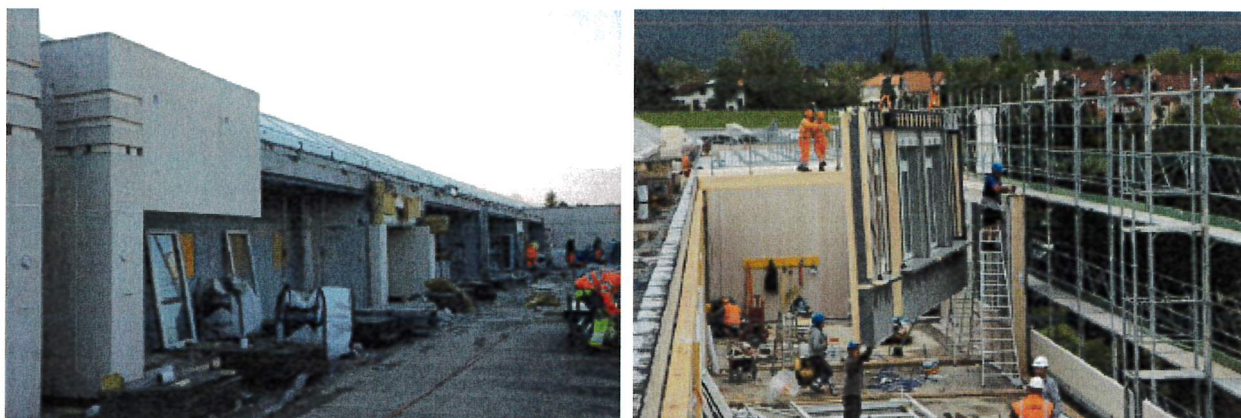
Pendant le chantier : à gauche, travaux de démolition, à droite, pose d'éléments de façade (photos © GT/ ARSCO SA).
