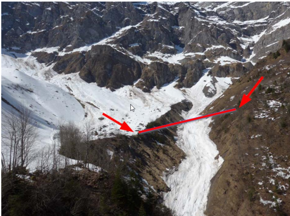
Abb. 3 geplante Leitungsquerung weit oberhalb der bestehenden Lawinenablagerungen
