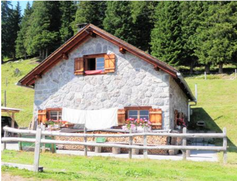
Abb. 4 Hütte Mittelstafel bestehend
