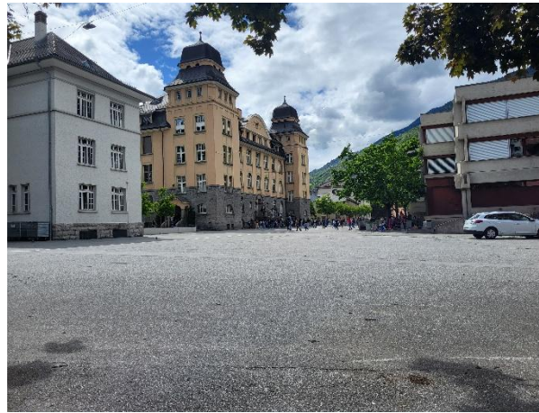
Abbildung 12: Schulhausplatz südlich des Schulhauses Hellmatten ist durchgehend asphaltiert. Der Platz weist zudem einen problematischen Nutzungskonflikt auf, da er auch als Parkplatz für Anwohnende genutzt wird. Bei einer Sanierung des Asphaltes, könnte eine kindergerechte Lösung erarbeitet werden, welche vermehrte Begrünung vorseht.
