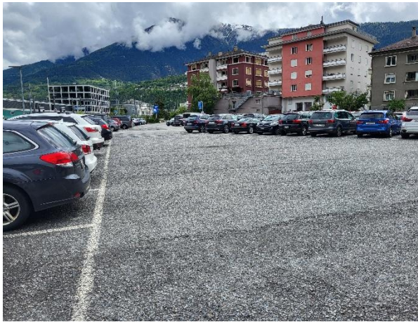
Abbildung 11: Der grosse Parkplatz beim Bahnhof West ist komplett asphaltiert und weist keine Beschattung durch Bäume auf. Bei einer allfälligen Sanierung bietet es sich an, die Fläche klimaresilienter zu gestalten – wobei auch die Biodiversität davon profitiert. Beispielsweise können die Parkflächen aus Rasengittersteinen angelegt werden und in einem regelmässigen Abstand Bäume mit genügen Wurzelraum gepflanzt werden.
