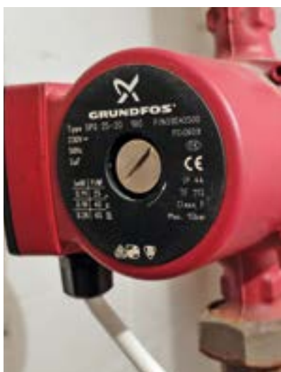
Hochwirkungsgrad-Pumpe der neuesten Generation mit elektronischer Drehzahlregelung.
