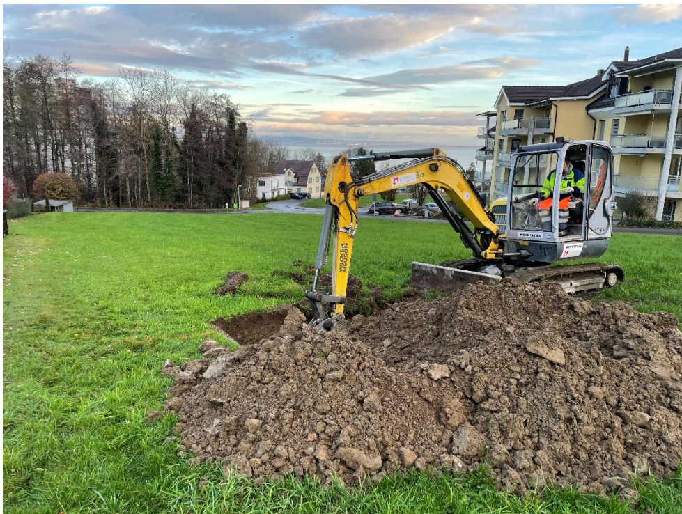
Bild 4: Bestandsaufnahme Dezember 2021 Sondage SW-Leitung, Sichtrichtung Nord)
