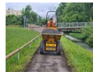
Renovationsarbeiten beim Gies-übelweg durch das Werkteam.
