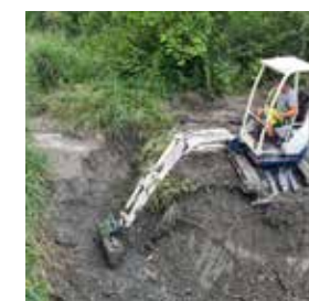
Baggararbeiten zur Sicherung von Rufen und Gewässern.
