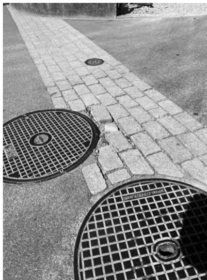
Defekte Pflasterung
