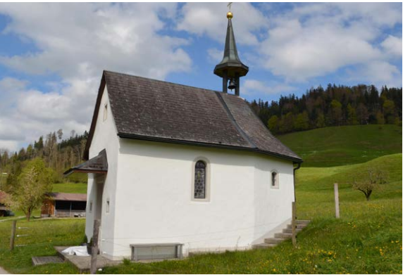
Die Grundkapelle wird gerade jetzt im Innern noch renoviert
