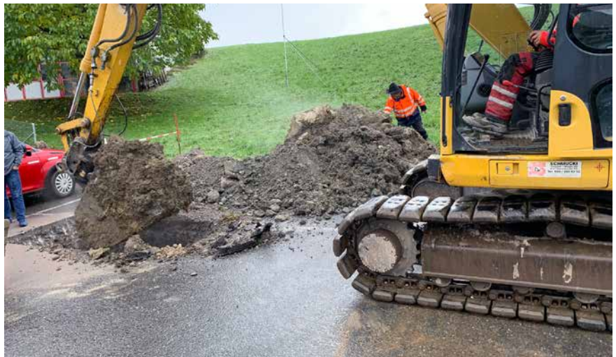
■ Baugrunduntersuchung auf dem Parkplatz Dorf.
