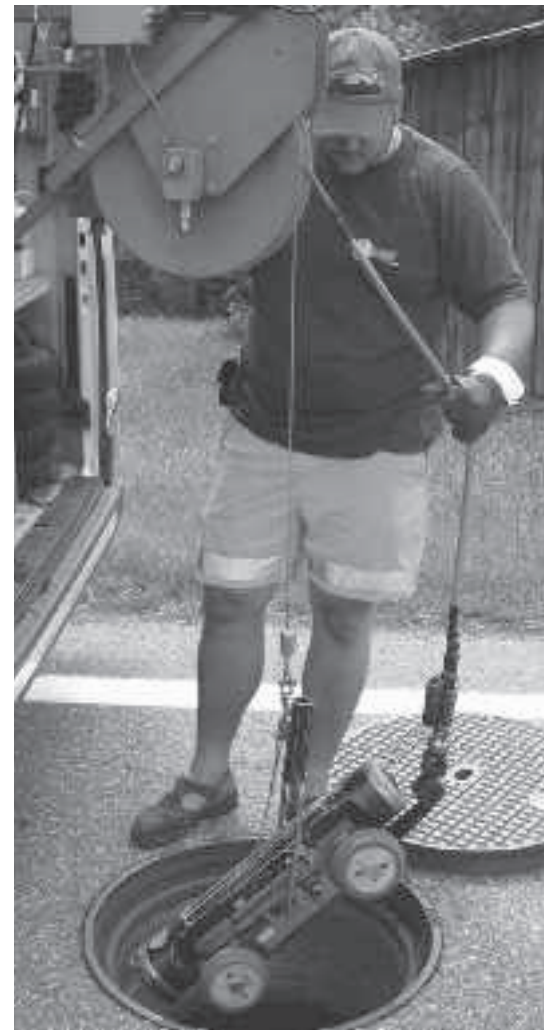
Die Kanalfernsehkamera wird sorgfältig in den Schacht eingeführt.
