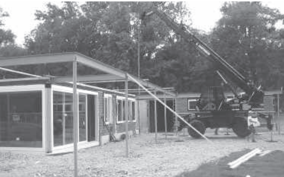
Schlussspurt beim grossen Bauprojekt: Ende August soll der Spiel- und Trainingsbetrieb aufgenommen werden.
