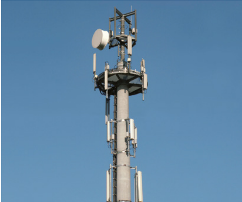
Die Baubewilligung für die Mobilfunk-Antenne ist erteilt.
